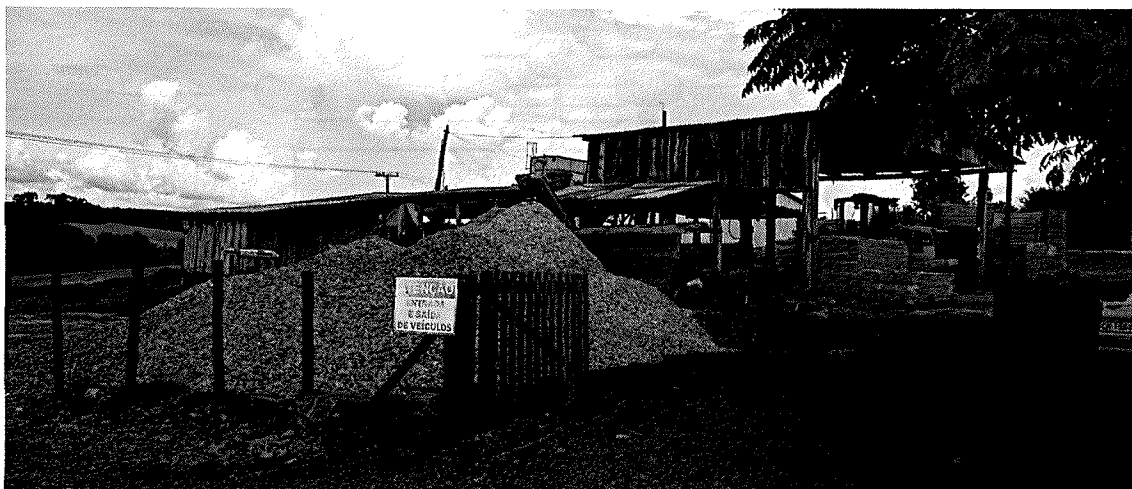
Figura 4: benfeitorias edificadas sobre o imóvel.
