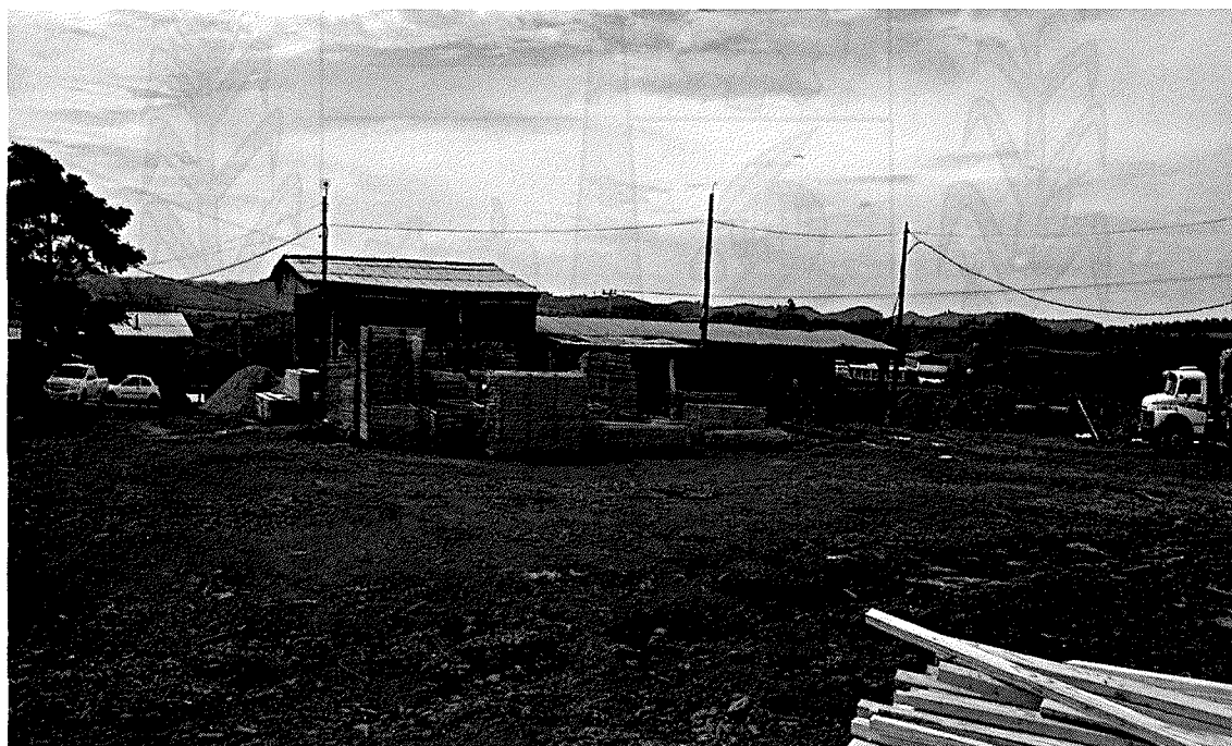
Figura 2: benfeitorias edificadas sobre o imóvel.
