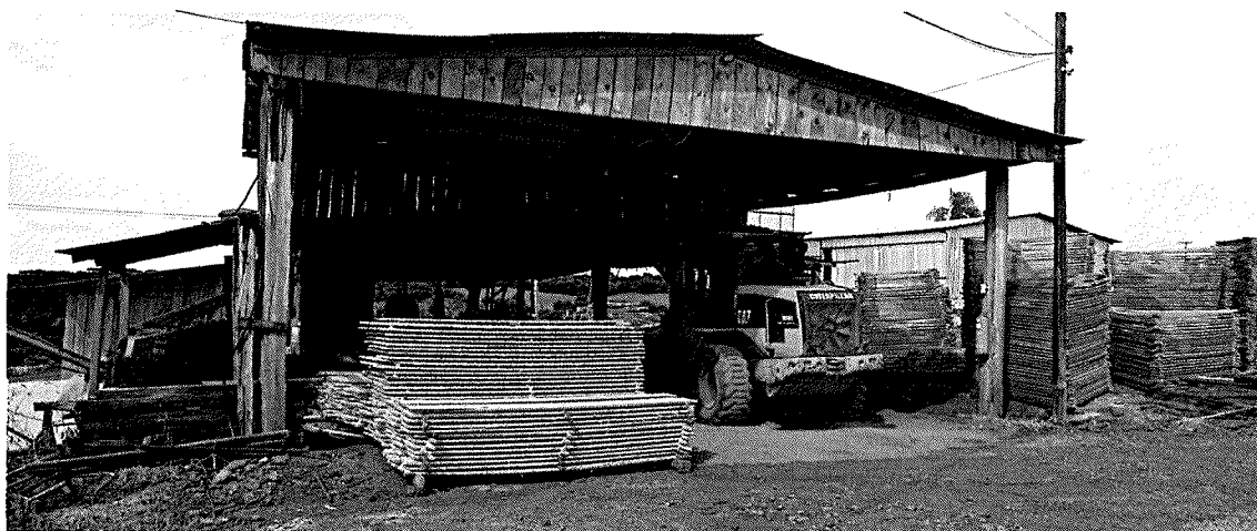
Figura 3: benfeitorias edificadas sobre o imóvel.
