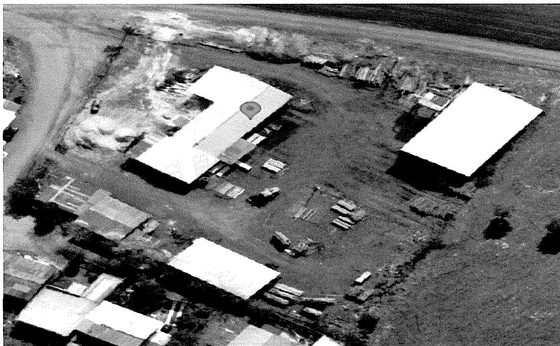
Figura 1: Localização aérea do imóvel.
